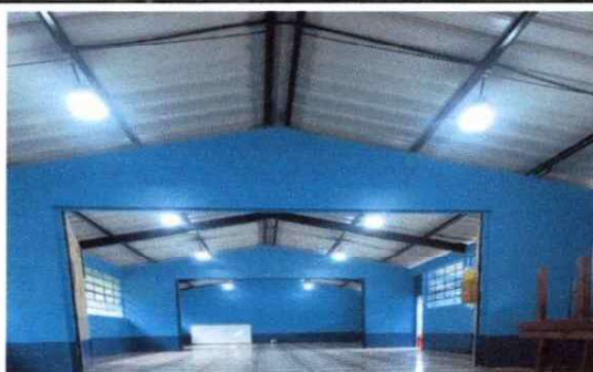
Foto 5: Reparacion de iluminacion del modulo de tres aulas. A quedado de esta manera la iluninacion de los modulos, corredor y direccion
