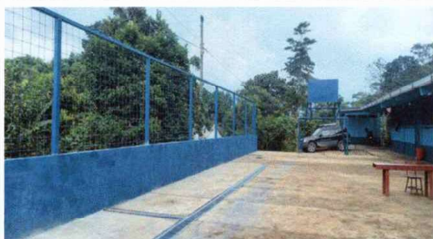
Foto 3: Mantenimiento de muro, quedo de esta manera
