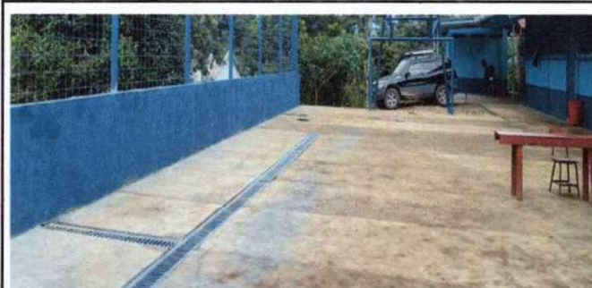
Foto 6: colocacion de rejilla por acumulacion de agua en patio. A quedado de esta manera la rejilla .
