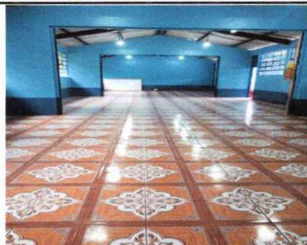
Foto 2: Sustitucion de piso de torta de concreto a piso ceramico, modulo de tres aulas y direccion, terminado y quedo de esta manera.
